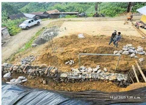
Foto 1: Avance de la construcción de muro de contención relleno de piedras
