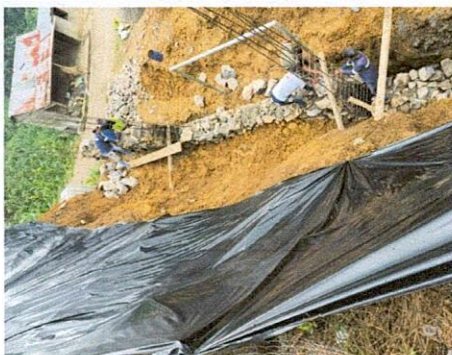
Foto 3: Cubierta de nylon para prevenir derrumbes debido a los cambios bruscos de clima
