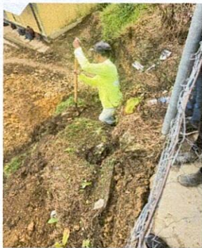
Foto 5: Retiro de tierra agrietada
