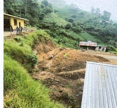
Foto 2: Vista de zanjeado desde ángulo derecho
