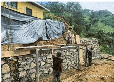
Foto 5: Avance de muro de contención, así mismo colocandole columnas de 5mts de largo x 2 de ancho
