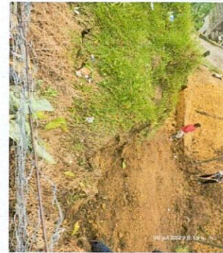
Foto 6: Retiro de tierra agrietada
