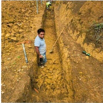
Foto1: Inicio de Zanjeado previo a cimiento
